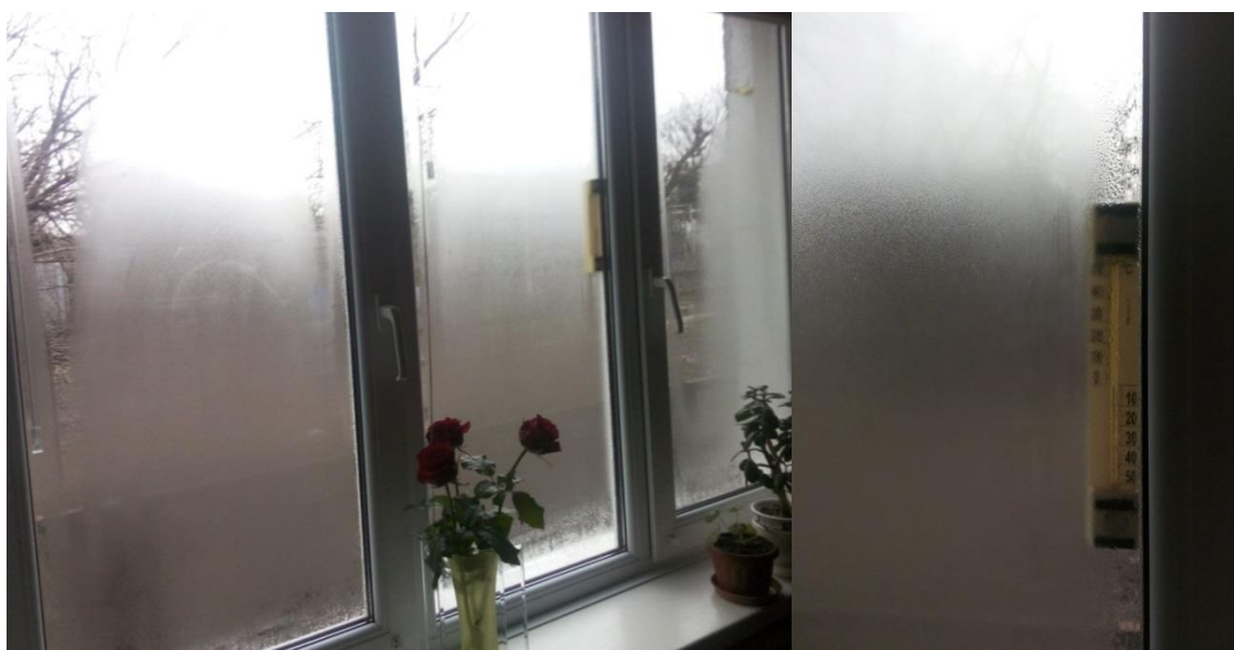
Рис. 1. Конденсат на склопакетах (температура зовнішнього повітря -1 \text{ }^\circ\text{C} )
