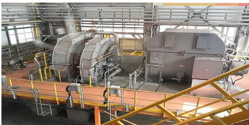
Рис. 1 Газова безкомпресорна утилізаційна турбінах (ГУБТ)
